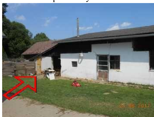
Kolna, dřevník, šipka - septik pod suchým WC
